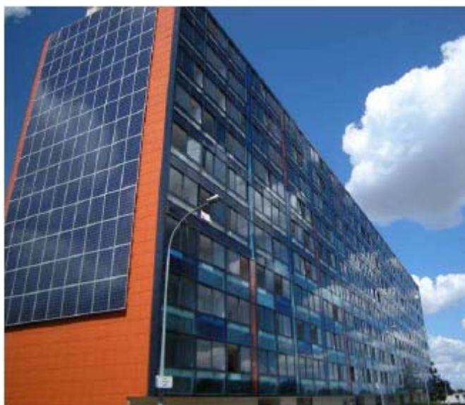
西南侧墙的 PV 阵列 (左侧) 和正面的 PV 阵列 (右侧)
