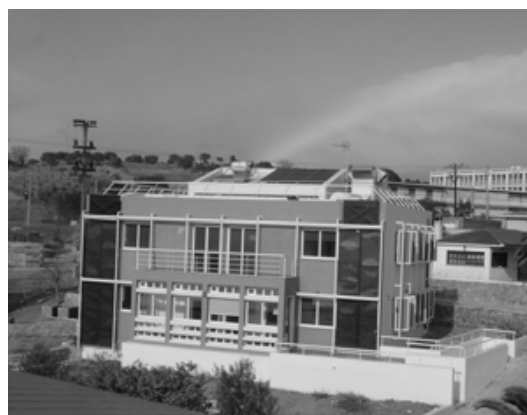
上图：太阳能集热器，面积 25m 2 ，位于建筑的南立面，与 16.7kW 的空气热泵相连
